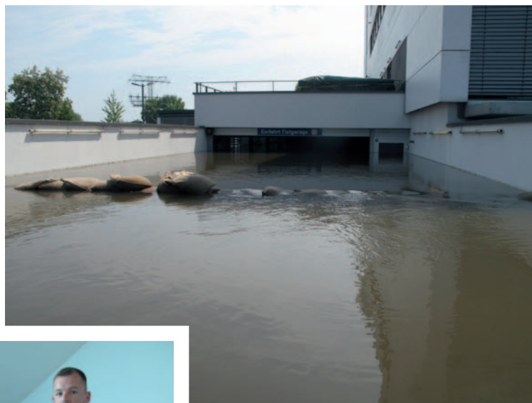
Die Einfahrt zur Tiefgarage vom VOTC. Am Sonntag stand darin das Wasser etwa 1,90 m hoch.
