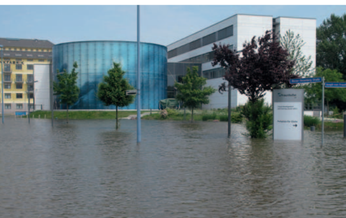
Sonntag, 9. Juni: Höchststand im Wissenschaftshafen. Das VOTC und die Denkfabrik sind völlig vom Wasser eingeschlossen. Ernsthafte Schäden im VOTC konnten verhindert werden.
